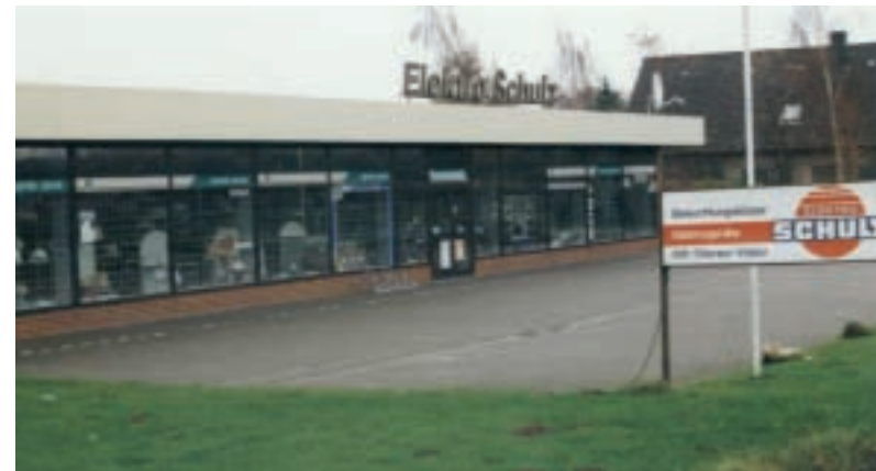
... der erste Neubau an der Schneiderkruger Straße im Jahre 1981 ...
