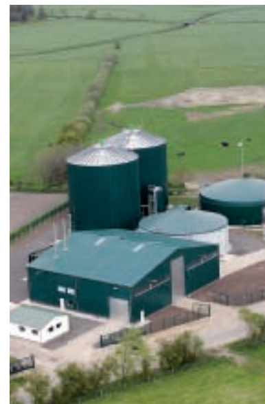
Biogasanlage in Viöl
